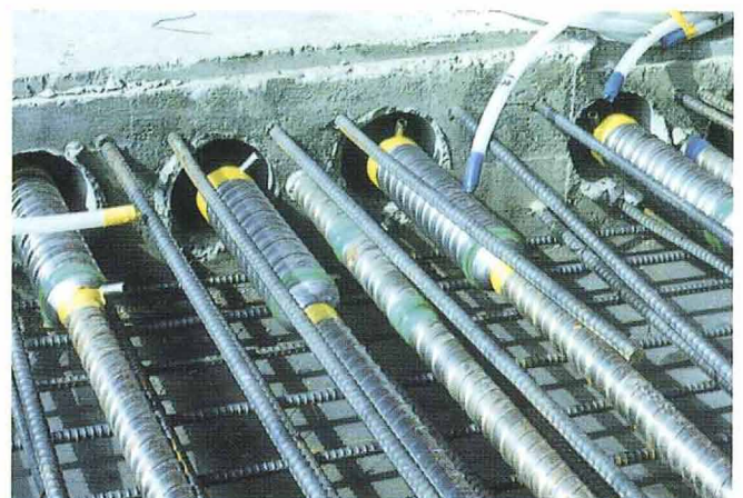
ディビダーク工法施工例
