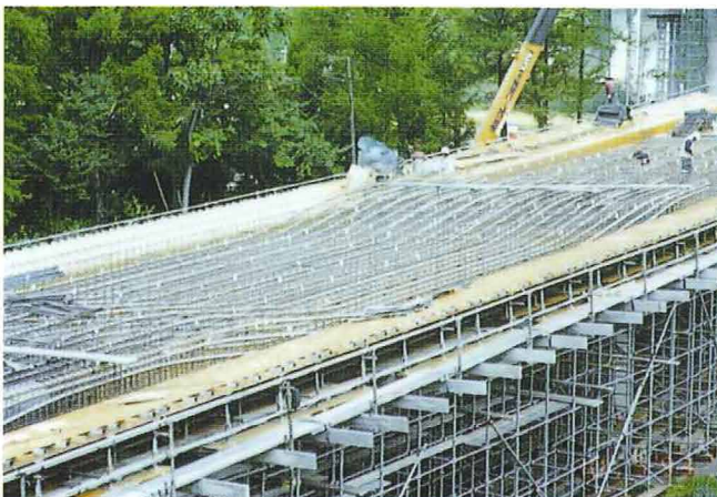
長野県、角間橋
