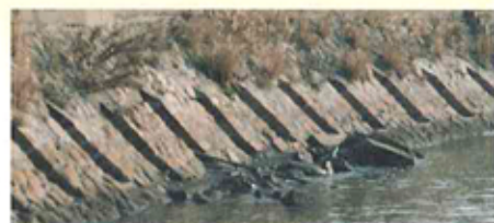
「長七たたき」の遺構： 旧四日市港潮吹き防波堤(三重県四日市市)
